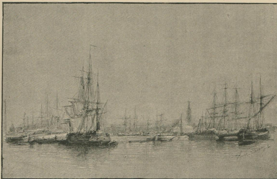
LES NOUVEAUX QUARTIERS MARITIMES. — VUE GÉNÉRALE DU BASSIN AUX BOIS.
